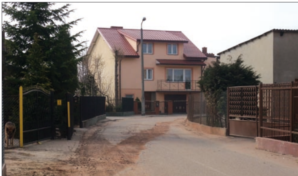
Ulica Jagielly po rozbudowie kanalizacji sanitarnej. W kwietniu nastąpi jej remont.
